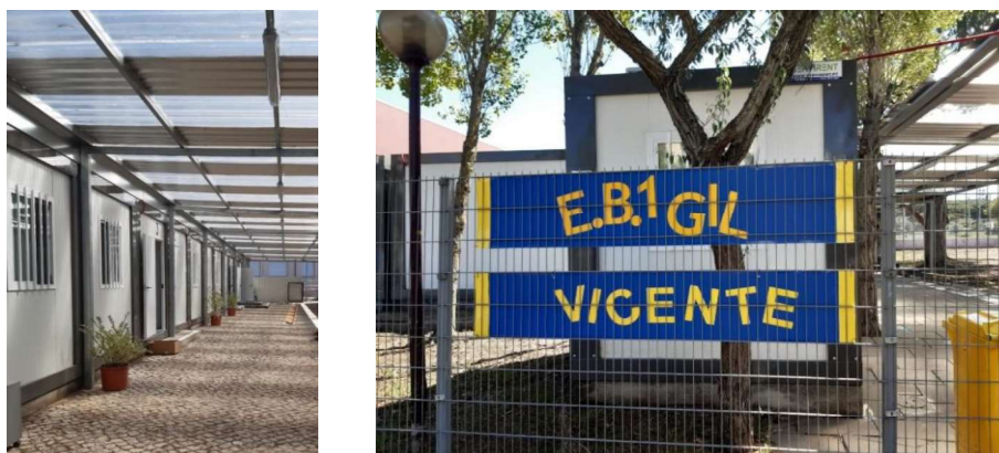
Fig. 115 – EB Gil Vicente - Instalações Provisórias
